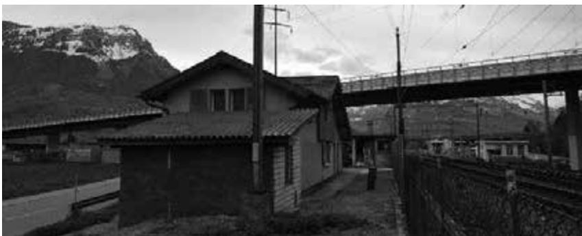
Die mittlerweile knapp dreissigjährige Fassade der Turnhalle Krummfeld wurde allseitig instand gestellt. Dabei wurden zum Schutz der Fassade die Dachränder mit zusätzlichem Dachvorsprung ausgebildet.
