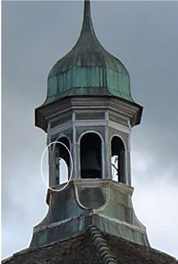
Montage in Turm
