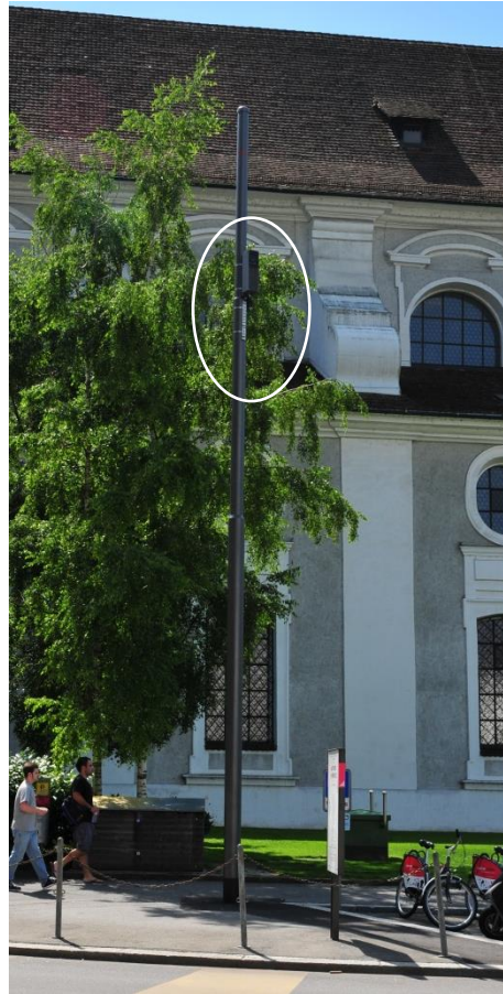
Montage an Mast
