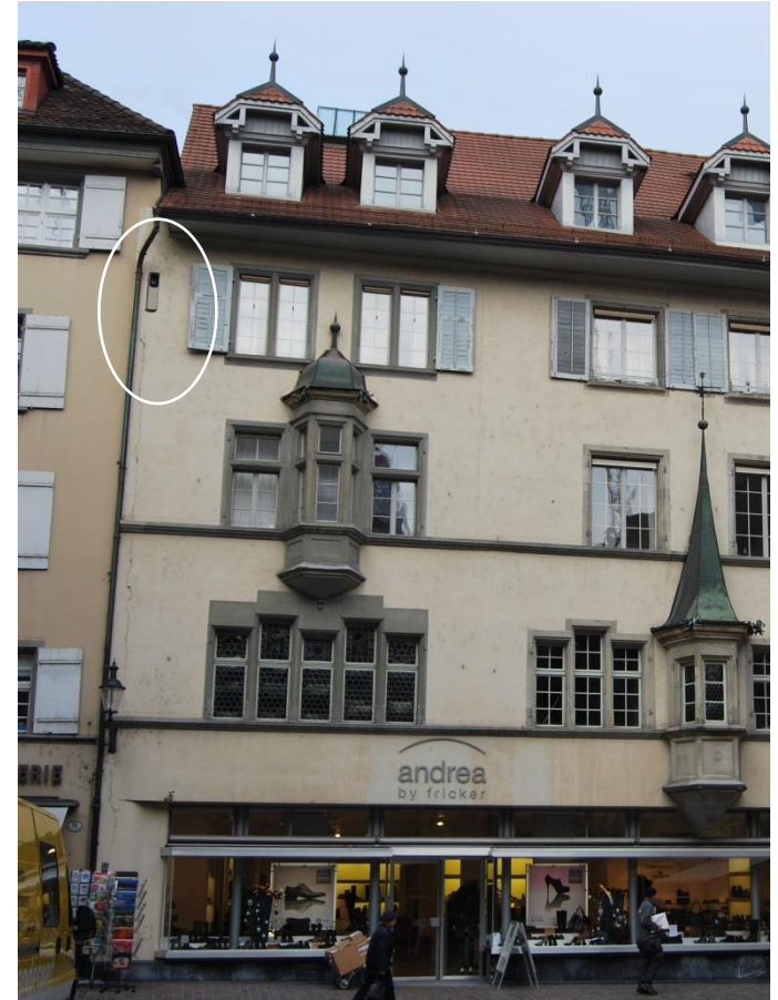
Montage an Fassade
