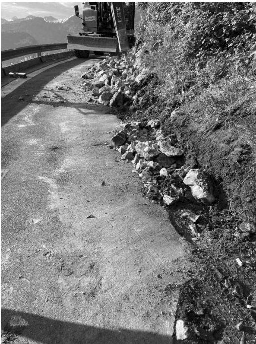
Anspruchsvolle Sanierung der Urmibergstrasse
