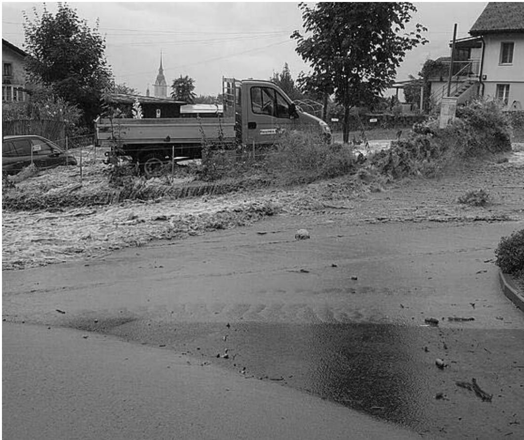
Beim Unwetter vom 26. Juli 2021 flossen die Wassermassen mit aller Gewalt durch dicht besiedeltes Wohngebiet und richteten grossen Sachschaden an.
