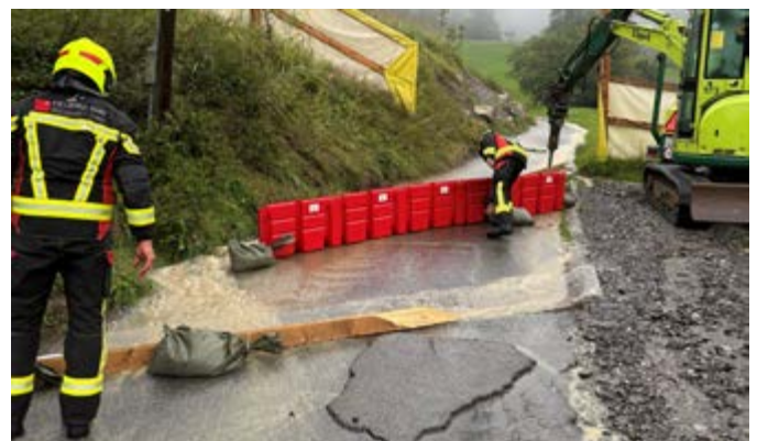
Noaq Boxwall im Einsatz beim Elementarereignis vom 28. Juli 2025.
