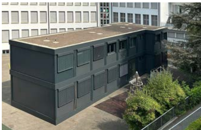
Der Schulraumpavillon beim Schulhaus Christophorus.
