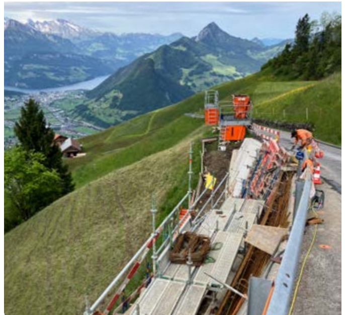
Sanierung der Stützmauer beim Utzenberg.
