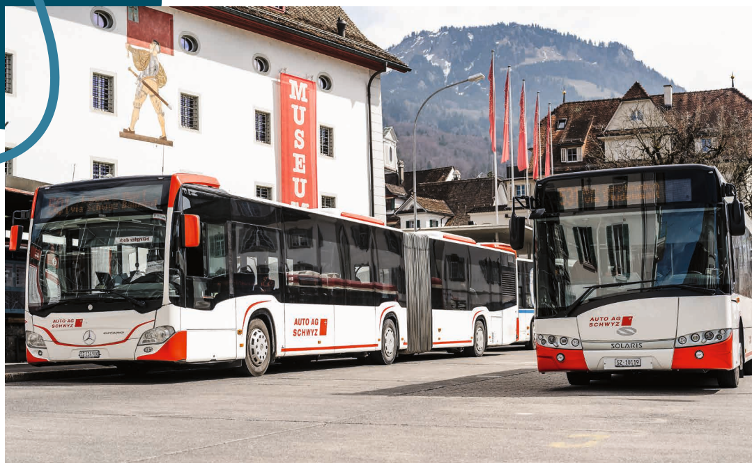
Der Bushof Schwyz vor Beginn der Bauarbeiten. Während des Umbaus bleibt der Busbetrieb mit provisorischen Haltestellen gewährleistet.
