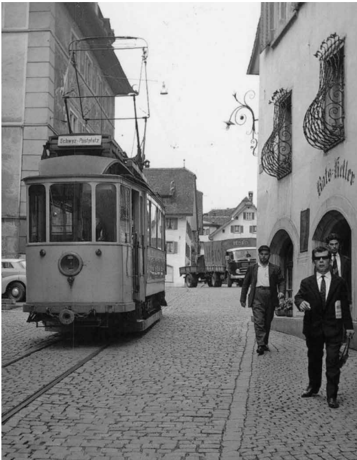
Die Strecke von Schwyz nach Brunnen führte in Schwyz über die Schützenstrasse via Ibach.
